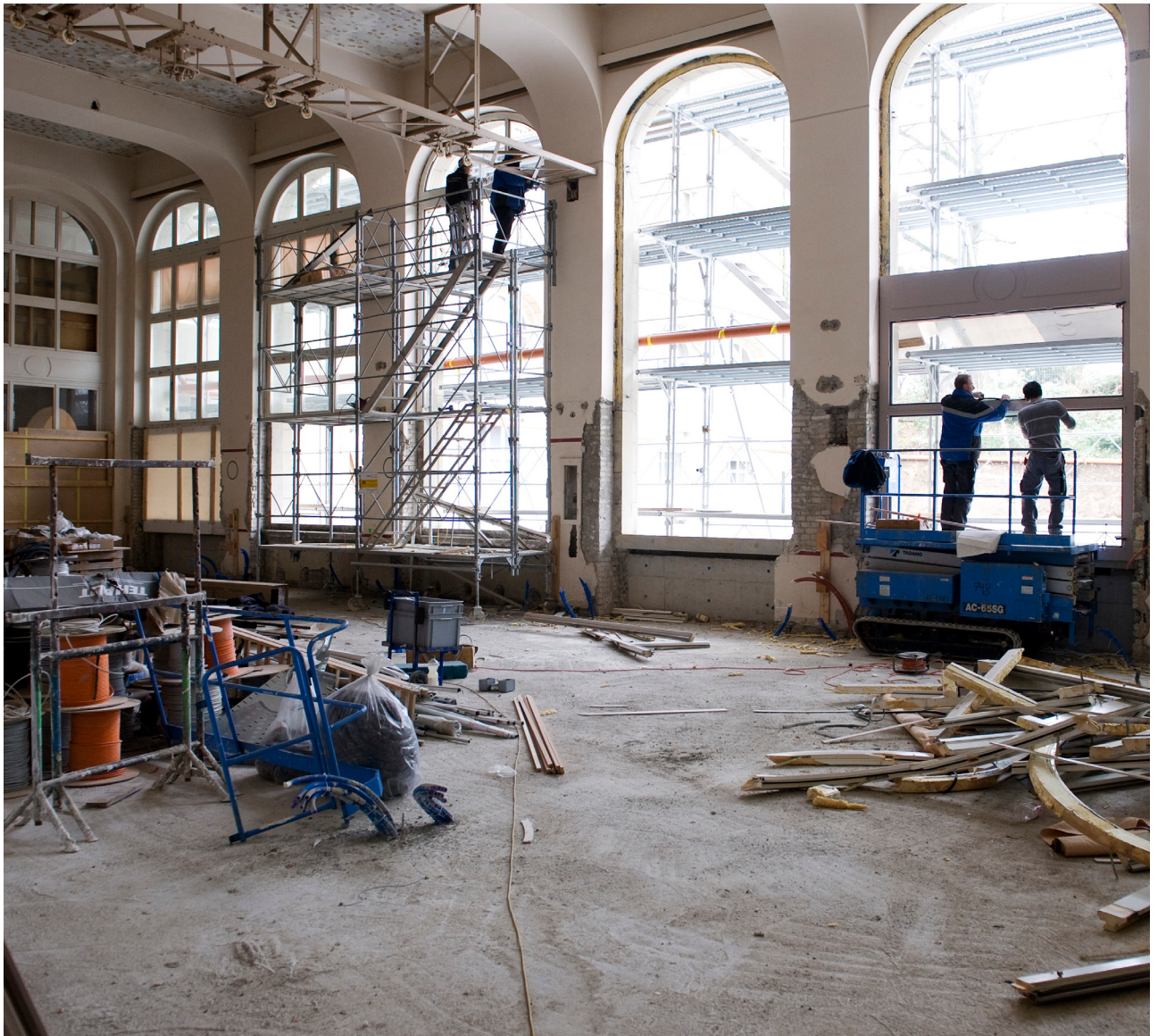
Sanierung der Kantonsschule Hohe Promenade: energetisch vorbildliche Gebäudesanierungen sollen häufiger werden. Bild: nzz/ Andreas Bodmer
